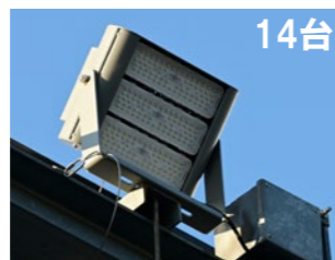
LED投光器 高圧ナトリウムランプ270形相当 定格消費電力:120W
