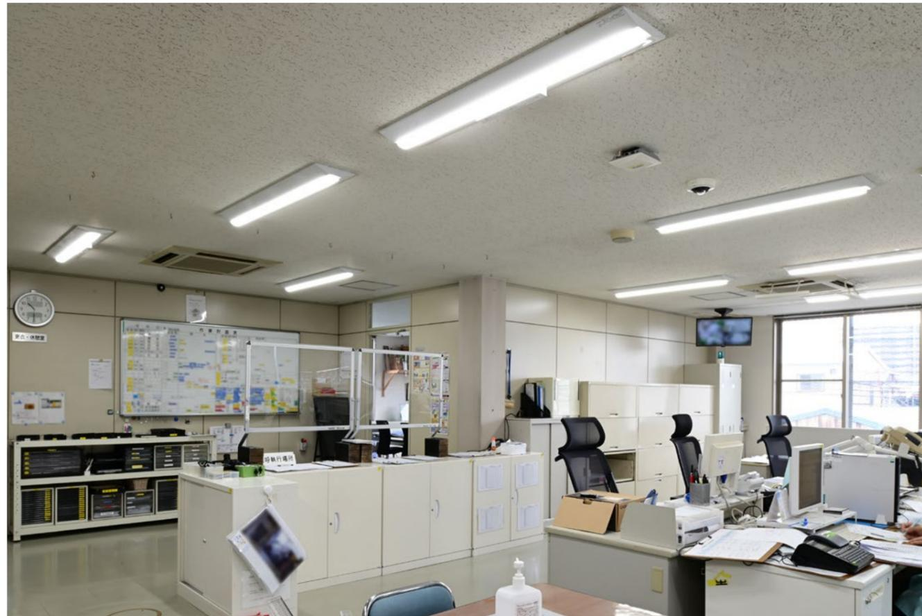
NIPPON EXPRESSホールディングスの一員として、50有余年続くキャッシュ・ロジスティクス事業の専門性を活かして全国規模のサービスを提供する同社は、このたび高知センターをLED照明器具に改修されました。改修にあたっては、部屋の利用目的に応じて適正照度を設定し、従来の蛍光灯照明器具よりもひと回り大きい230mm幅の器具本体を選択することで旧器具の取付跡が目立たず、見映えよく改修できました。快適な明るさが長続きする高効率なLED照明への切り替えによって約66%の消費電力削減が見込まれ、200本近い蛍光灯のメンテナンス作業も解消。快適な照明環境にご満足いただいています。
